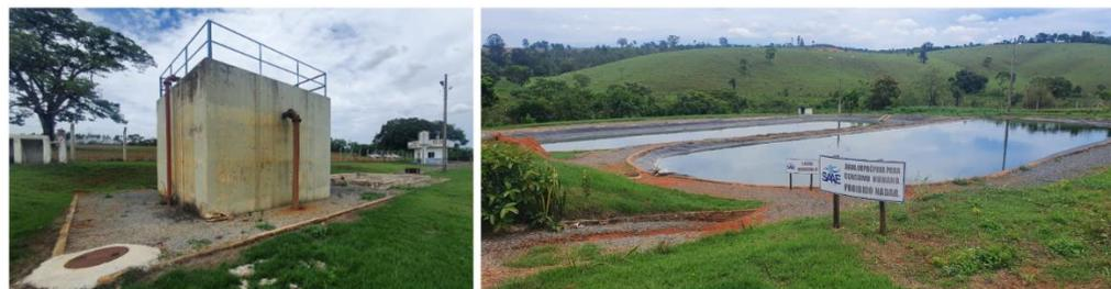
Figura 02: Vista o reator UASB e para as duas lagoas facultativas (ETE do Campinho) (19°55'41"S; 45°41'49"O). Fonte: Os autores (2024).
